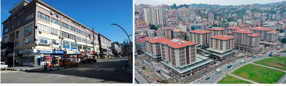
Resim 18-19: 2021 yılında kentsel dönüşüm projesi kapsamında yıkılan Belediye Bloklarının yerini yeni modern bloklar almıştır.
